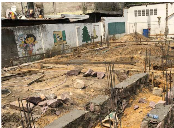
Baustelle des Kindergartens im September 2018
