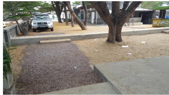
Der sanierte Platz mit zugedeckter Drainage
