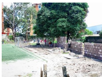
Während des Baus
